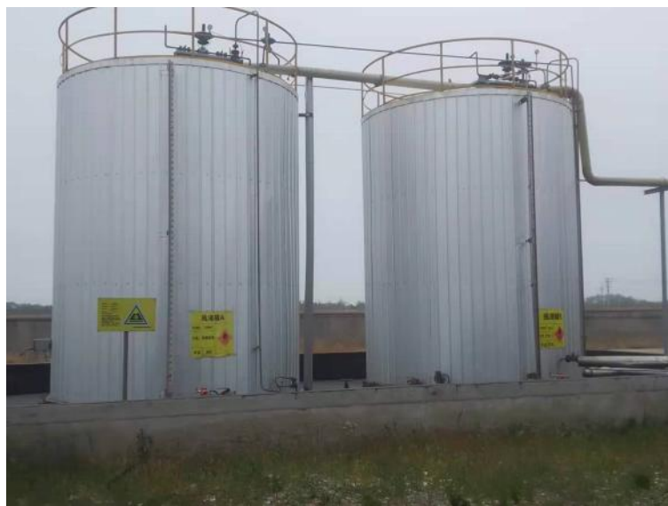
图 3.3-4 现有待焚烧残液罐区照片
