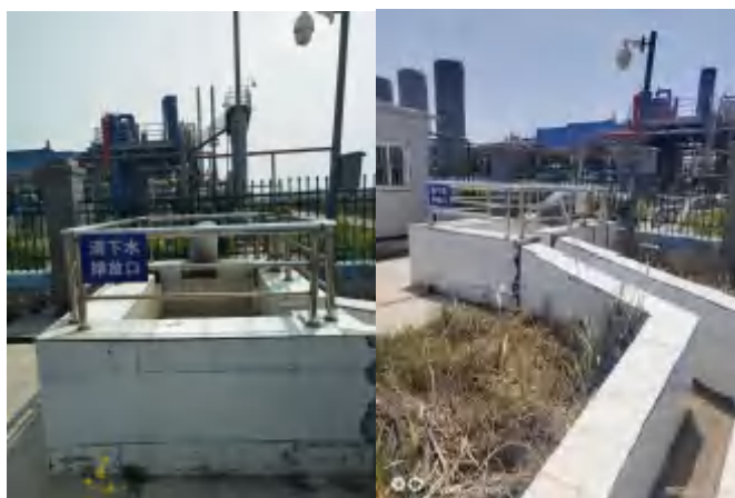
图 2.5-11 企业雨水排放口及在线监控设备现场照片
