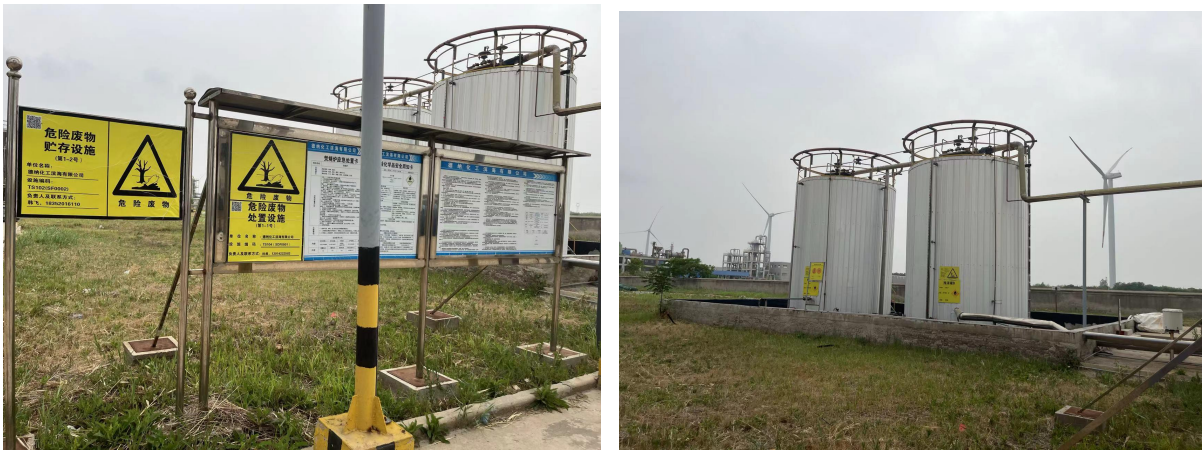
图 4.1-8 厂区残液罐区照片
