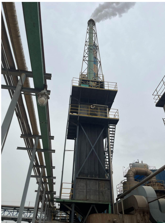
图 4.2-2 废气排放口设置情况
